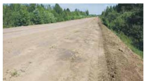
Работы ведутся на участке дороги с 1 по 3 км. В настоящее время выполнено закрепление оси трассы, ликвидированы неровности верхнего слоя грунта, завезен щебень.
